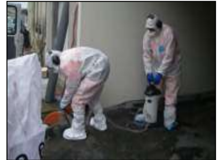
Sciage de chaussée
